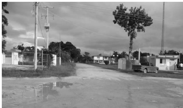
Foto 7.- Vialidad de terracería Fuente: Archivo personal
