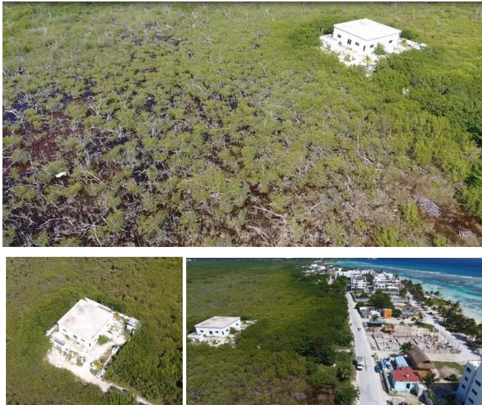
ILUSTRACIÓN 29: PLANTA DE TRATAMIENTO, MAHAHUAL.
